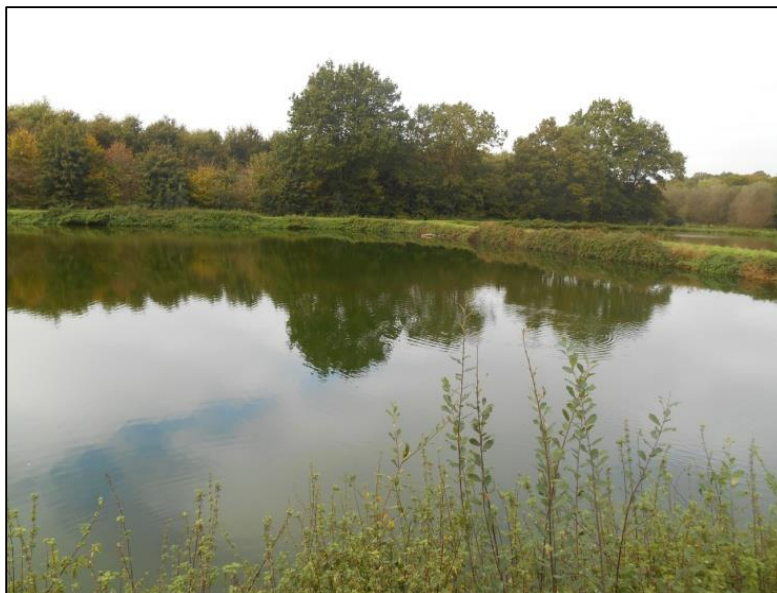
Photo 2 : Vue de la station d'épuration communale (1 er bassin)
