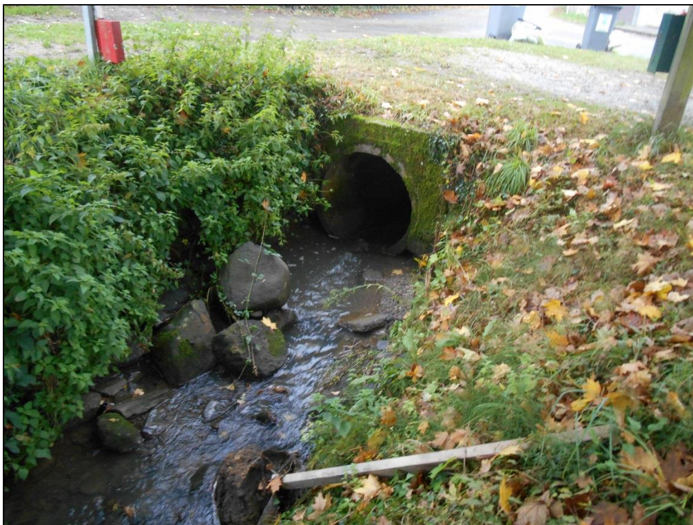
Photo 3 : Vue du ruisseau de Pont-Riou busé à la sortie du bourg (Ø1000)
